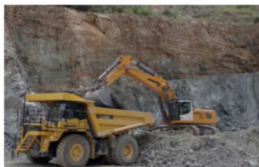
Carrières Travaux d'extraction, broyage, concassage...
