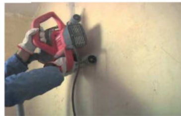
Électricité Saignée, rainurage dans mur en béton
