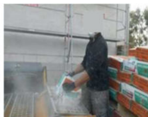
Ravaleur, maçon Grattage d'enduit, malaxage...
