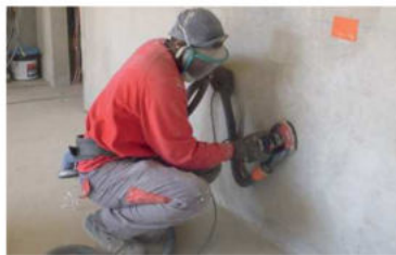
Travaux de maçonnerie Ponçage de béton...
