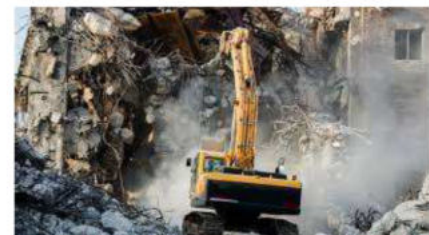
Démolition Avec engins
