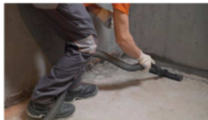
Nettoyage de chantier
